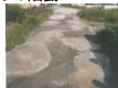
農道の窪みの補修
