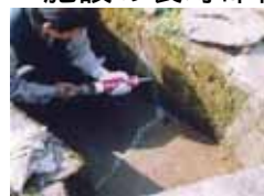
水路のひび割れ補修
