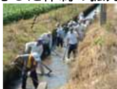
水路の泥上げ
